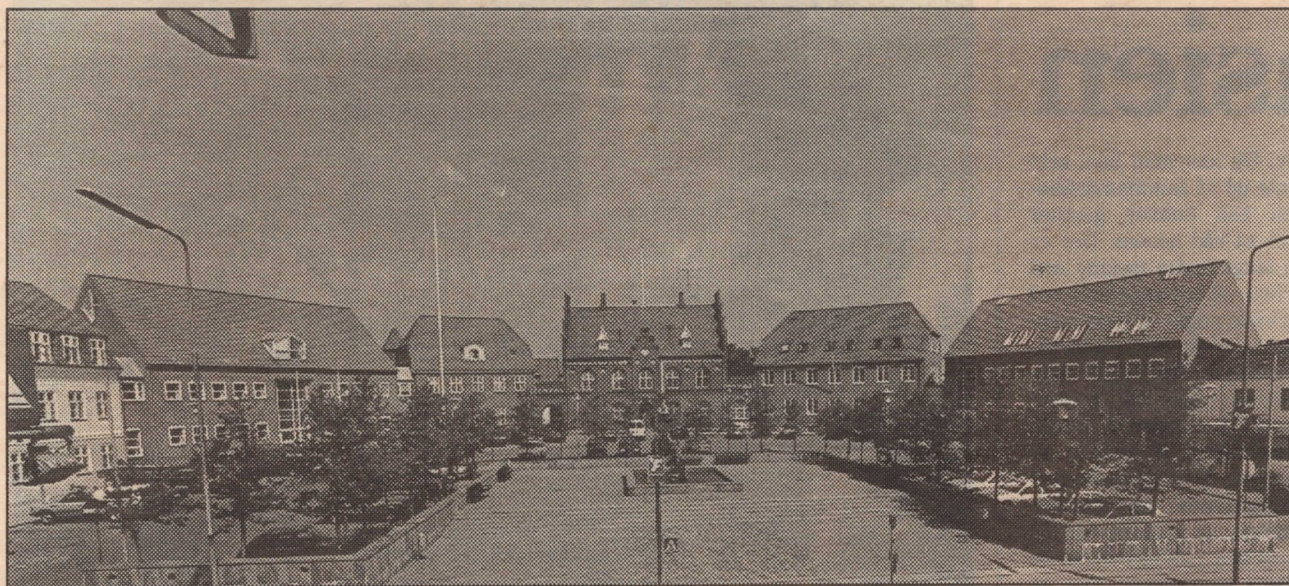
Frederikssund har nu fået lukket sit halvcirkelformede torv. To nybygninger - rådhusets hovedbygning og Kreditforeningen Danmarks kontorbygning (yderst til venstre og højre på fotoet) - er profilmæssigt indpasset i den bestående husrække. Fotos: Poul Ainow.
