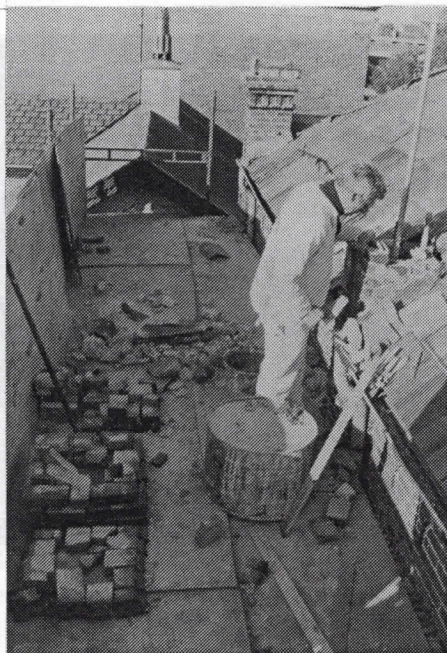
Frontpartiet mod gaden mures om - formsten lagt ud på stilladset bag muren.
